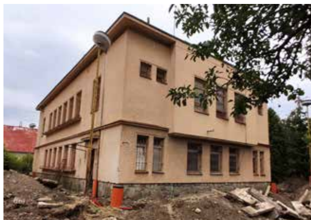
Obr. 1. Výkopové práce okolo Múzea Martina Benku. Foto M. Váleková, 2020. Fig. 1. Groundworks around the Martin Benka Museum. Photograph by M. Váleková, 2020.
